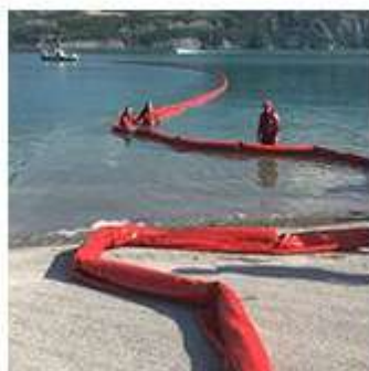
Barrage de confinement déployé sur un lac
