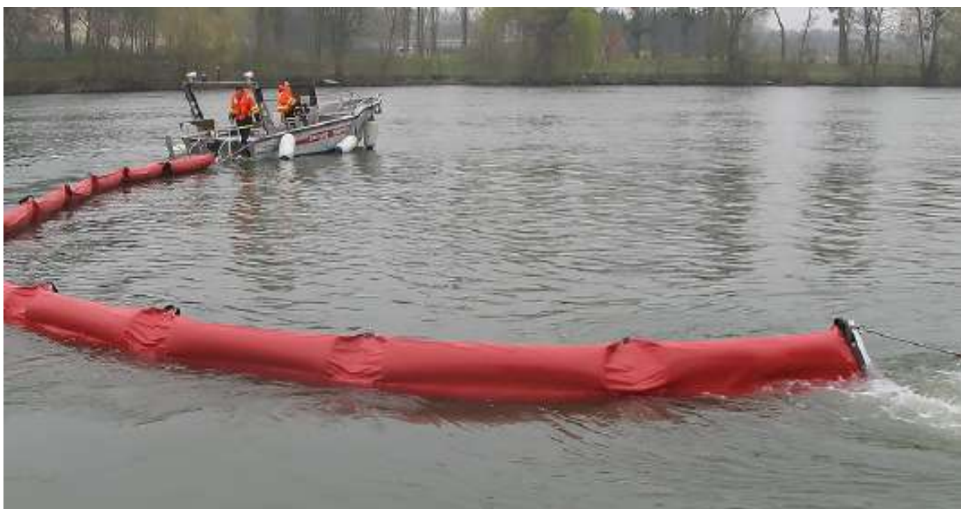
Barrage installé dans un bassin de décantation
