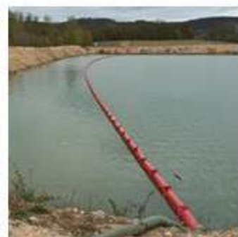
Barrage installé dans un bassin de décantation
