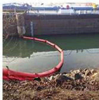
Barrage de confinement pour station d'épuration
