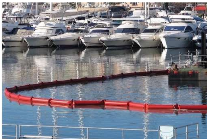
Barrage anti-turbidités filtrant adapté pour les travaux maritimes
